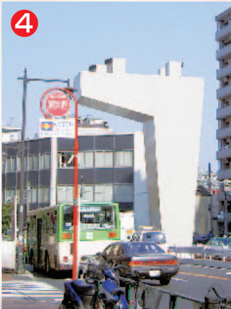
現在橋脚を建設中。
